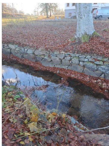
Detta dike med stensatta sidor kan också vara stenarbetaren Johannes Jönssons verk
